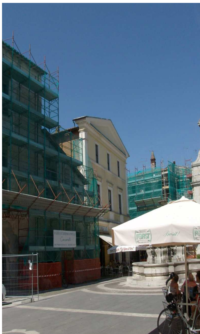
Sutri, lavori di restauro palazzo comunale (Palazzo Altoviti XVI sec.)
